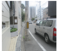
道幅が狭く凹凸が激しい
